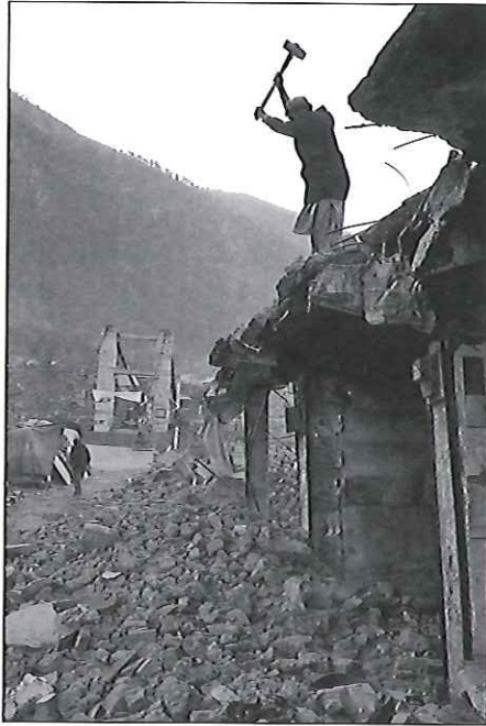
Hela staden slås sönder i små bitar med släggor för att komma åt armeringsjärn, tegel, sten etc.
