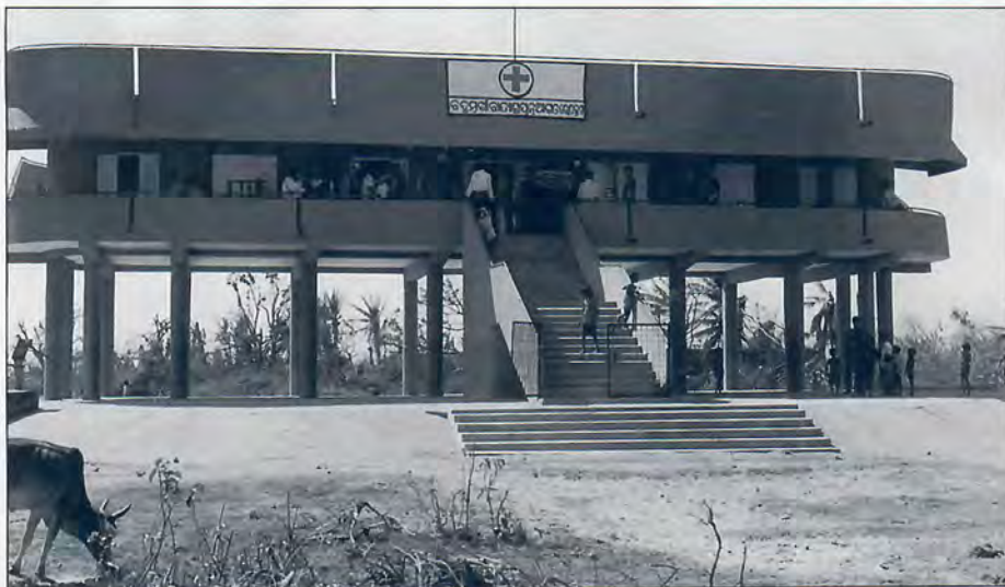
Under senare år har bl a Röda Korset byggt några cycloncenter av det här slaget längs kusten. I Nuagarh-centret på bilden räddades 1 800 människor från en säker undergång. Det finns förslag hos delstatsregeringen om att bygga om byskolor till cycloncenter.
