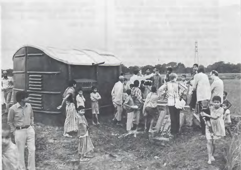
Mycket bistånd går till moderna bevattningsanläggningar. Här en SIDA-delegation vid en nyinstallerad rörbrunn i norra Bangladesh.
